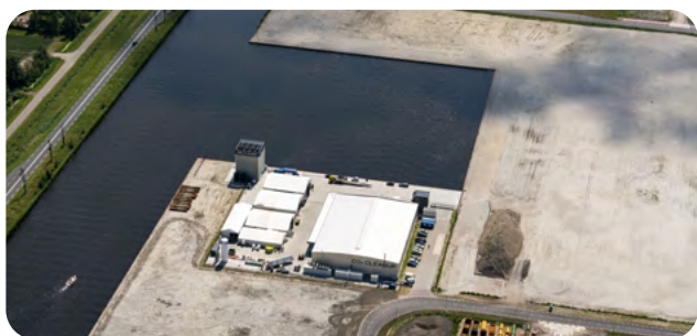
5 MWh Batterij bij de insteekhaven van de Boekelermeer
